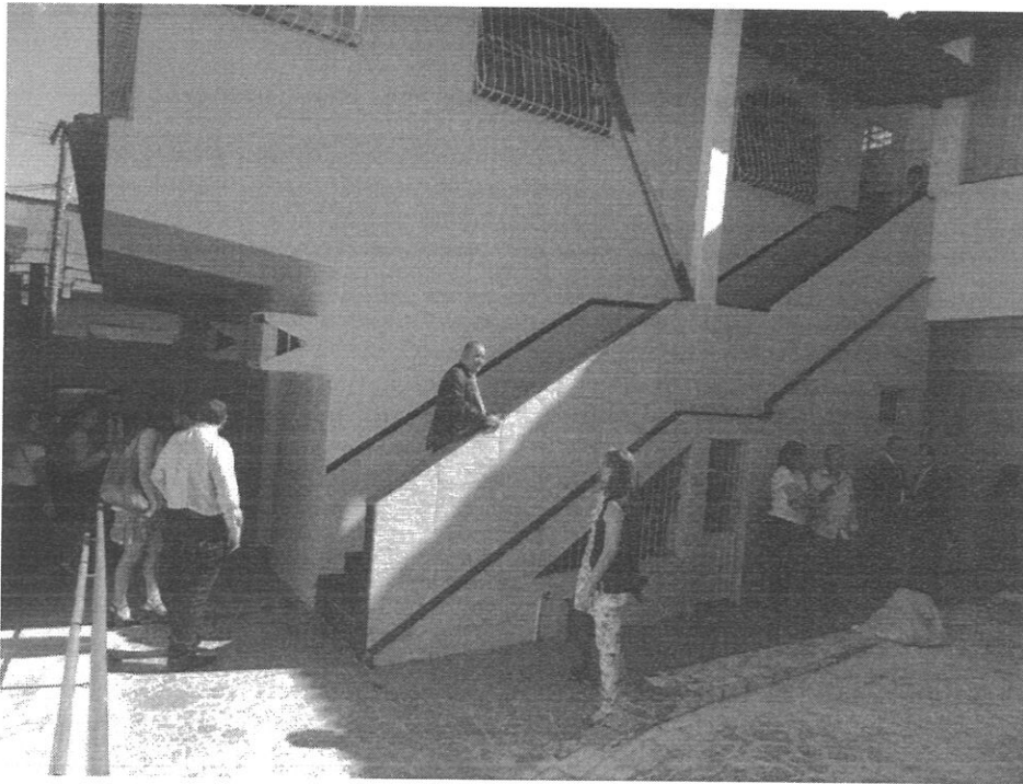
Escadas dificultam acesso. Foto: Divulgação.
